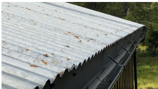
Synlig utettheter med spikeropptrekk
