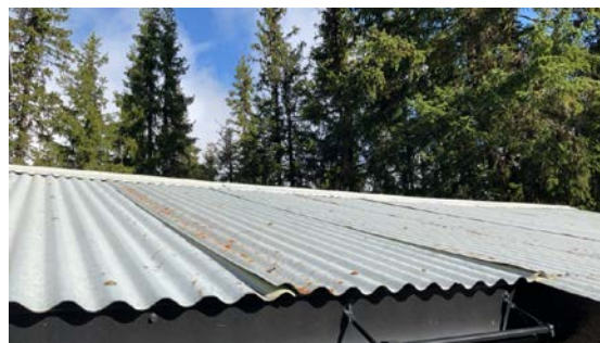
Løs skjøtende med fare for klapping
