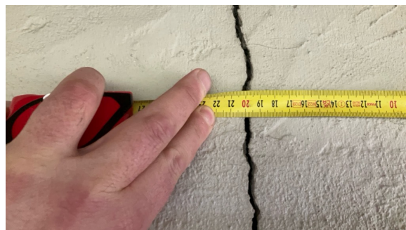
Det er påvist sprekker i murte/pussede fasader.
