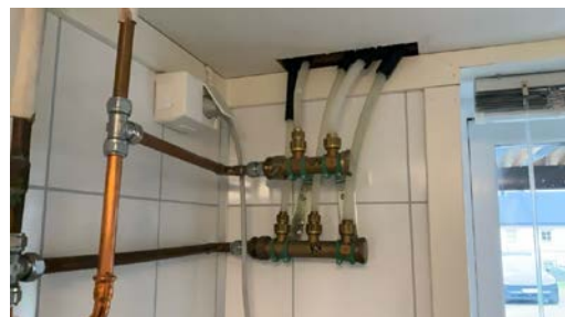
Fordelerstokker montert åpent på vegg.
