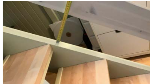
Åpninger i rekkverk er større enn dagens forskriftskrav til rekkverk i trapper.
