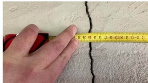
Det er påvist sprekker i murte/pussede fasader.
