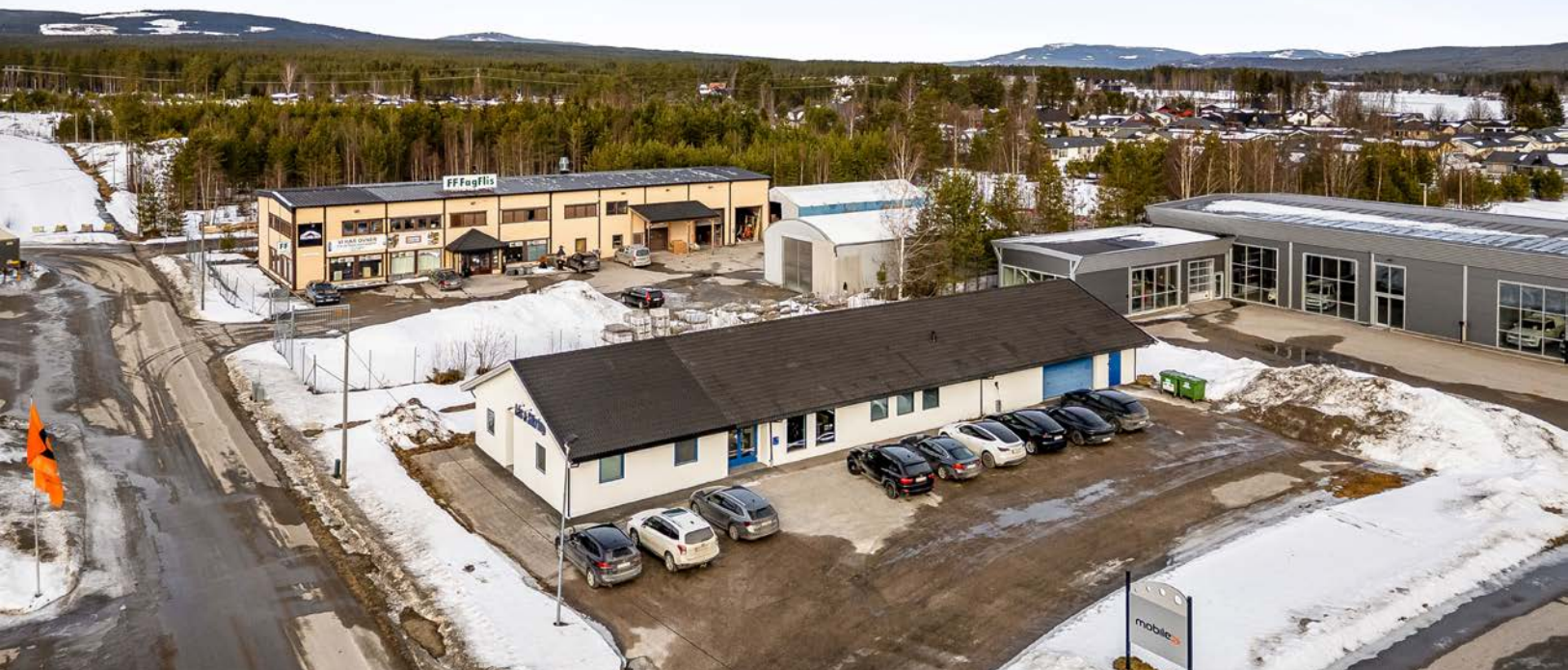
Næringseiendom med tilnærmet flat eiet tomt på ca. 2 349,9m 2 . Asfalterte eller grusede områder med parkerings-, innkjørings og lagringsplasser.
