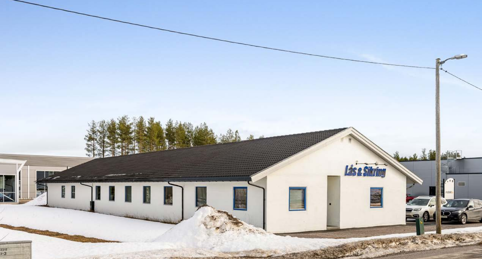
Tilbygget i 2019 mot sydvest med kontorer og korridor. Bygningsmasse ved næringsbygget med en etasje oppført i Leca. Yttertak tekket med betongtakstein, tekking fra 2003/2019.
