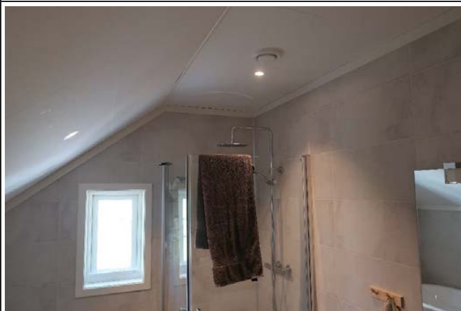
7.2.1 Bad i 2. etasje Overflate vegger og himling
