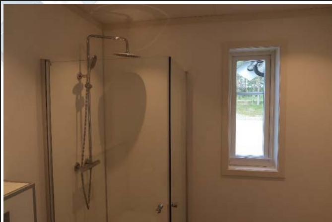
7.1.1 Bad i 1. etasje Overflate vegger og himling
