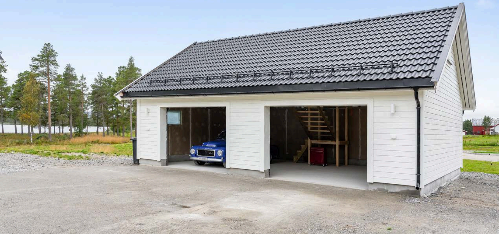
Garasjen som ble oppført i 2023 har to separate innkjøringsporter, begge med el-styring på selve porten.
