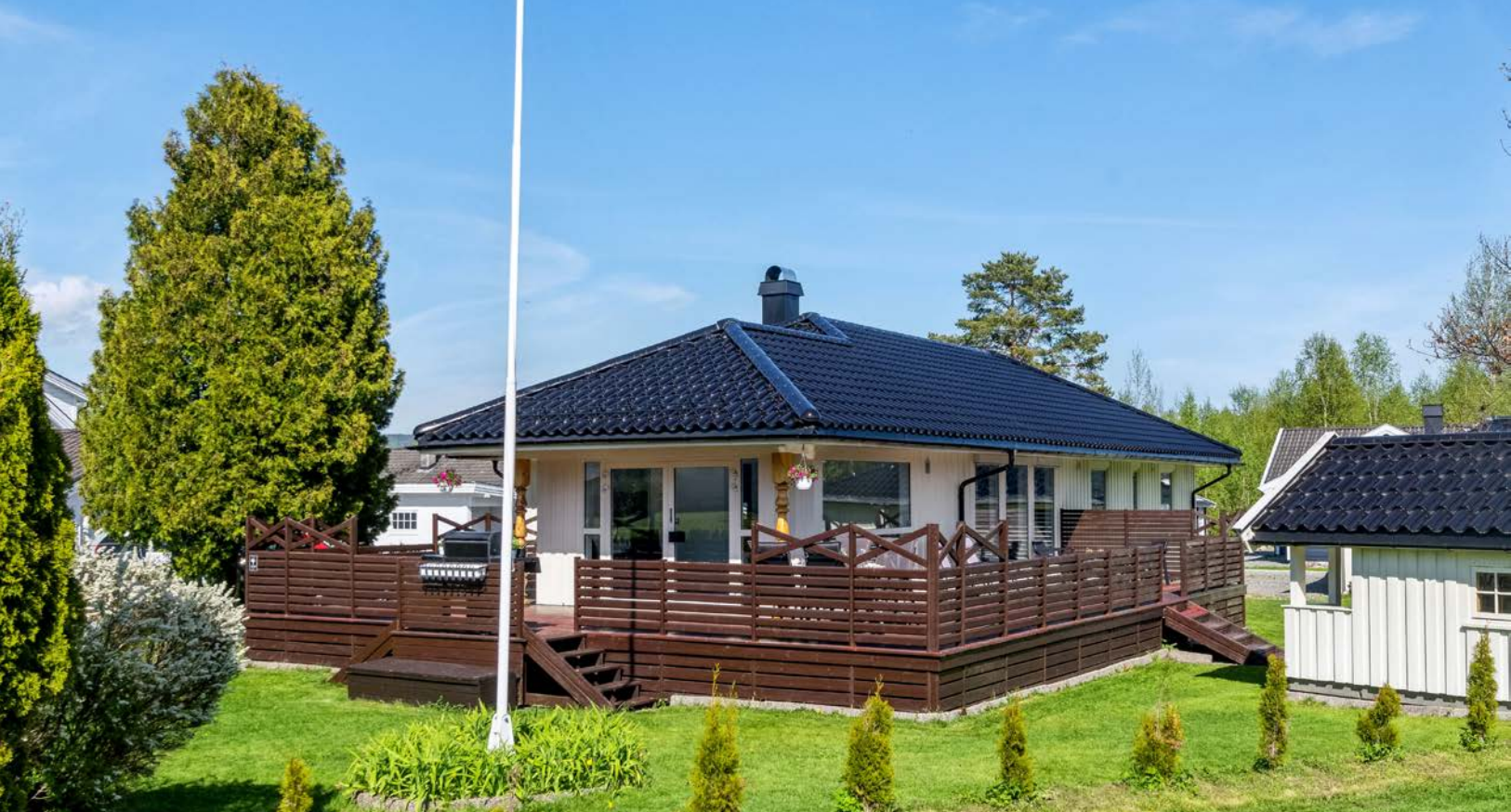
Huset har flott tak med Hollandsk glasert takstein fra 2020.
