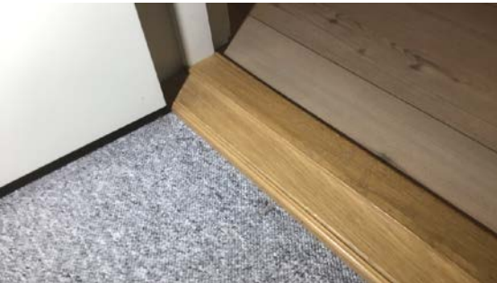
Mangler luftespalte under/over dørblad
