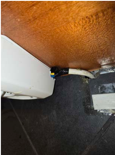
Bilde 3 Kabel avisolert utenfor kappe
