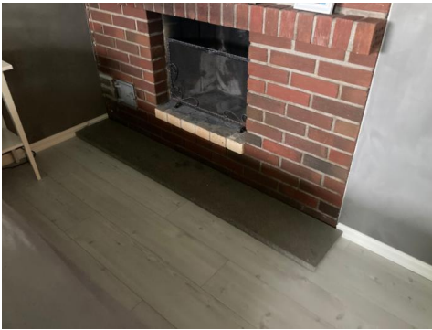
Peis i soverom underetasje.
