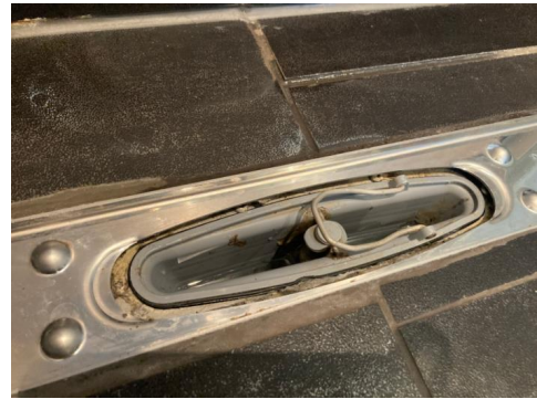
Veggsluk i dusjsone.
