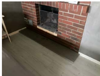
Peis i soverom underetasje.
