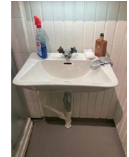
Trepanel i våtzone til servant og dusj.
