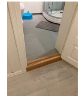
Gulvfliser er behandlet med våtromsmaling.
