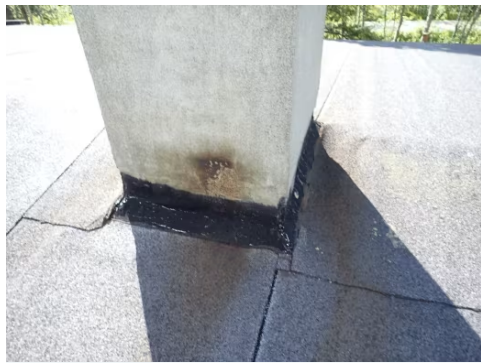
Svakheter i beslag/tekkning.
