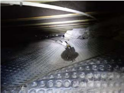
Oversiktsbilde. Viser synlig vann og utførelse av fuktsperre på bakken.
