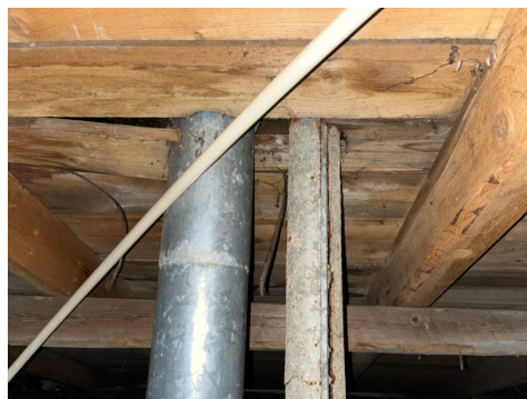
Uisolert luftekanal.
