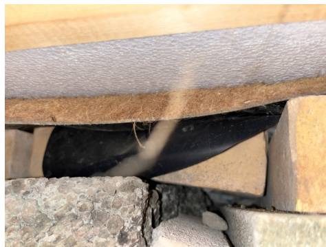
Isopor i bjelkelag.
