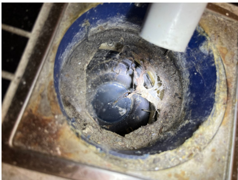
Ikke klemmt mansjett i sluk
