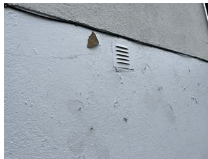
Flass i overflater murvegg.
