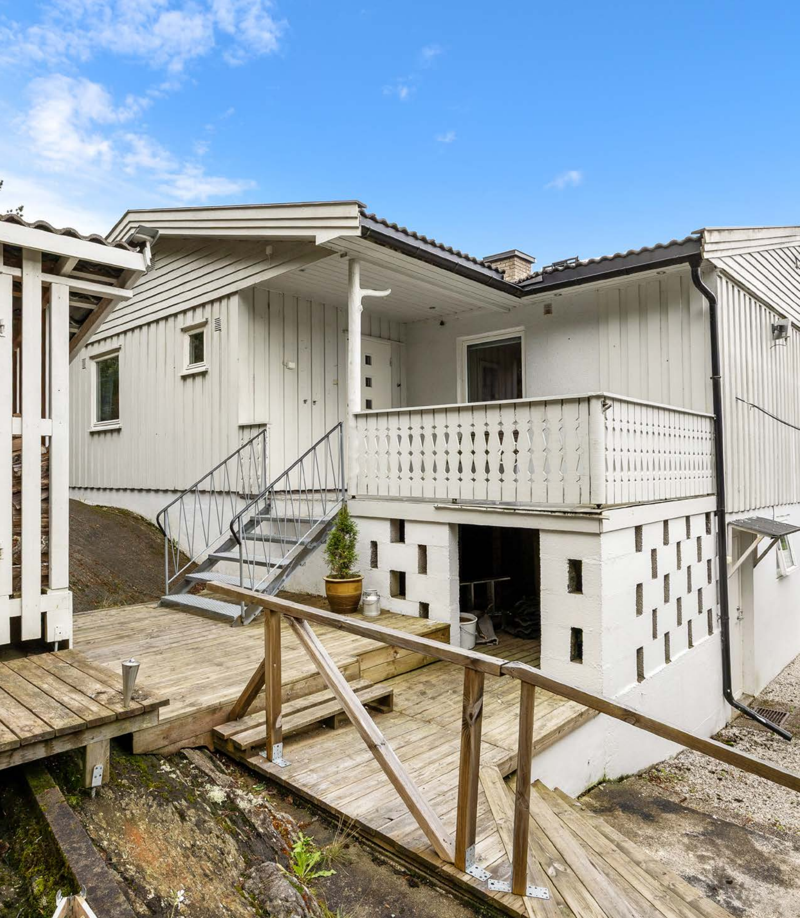
Boligen har et pent, overbygd inngangsparti med velkomstterrasse og takmontert utebelysning.
