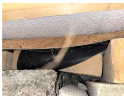
Isopor i bjelkelag.
