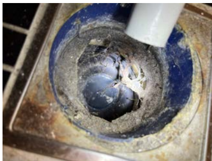
Ikke klemt mansjett i sluk
