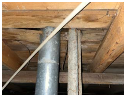
Uisolert luftekanal.
