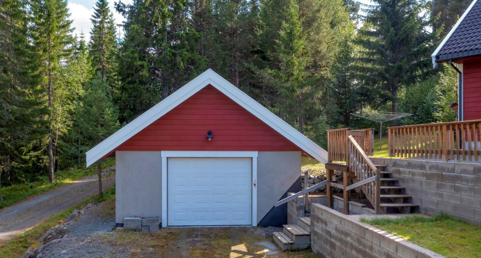
Frittstående garasje med trapp ned fra boligen
