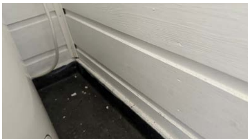
Malt trepanel på veggene.
