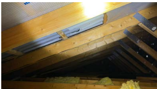
Skade/manglende undertak
