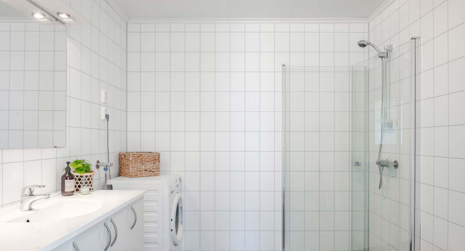
Leiligheten har et lyst og moderne baderom fra byggeåret 2014. Badet rommet har flislagt gulv med gulvvarme, lyse våtromsplater på veggene og mekanisk avtrekk.
