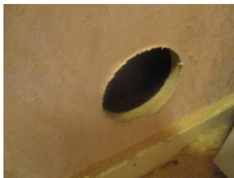
Hulltaking i fra gangen.
