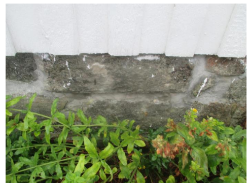
Deler av grunnmur.
