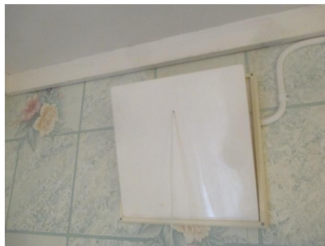
Avtrekk i ytterveggen.
