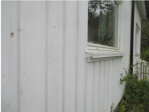
Fasade i front er blitt kledd på nytt.
