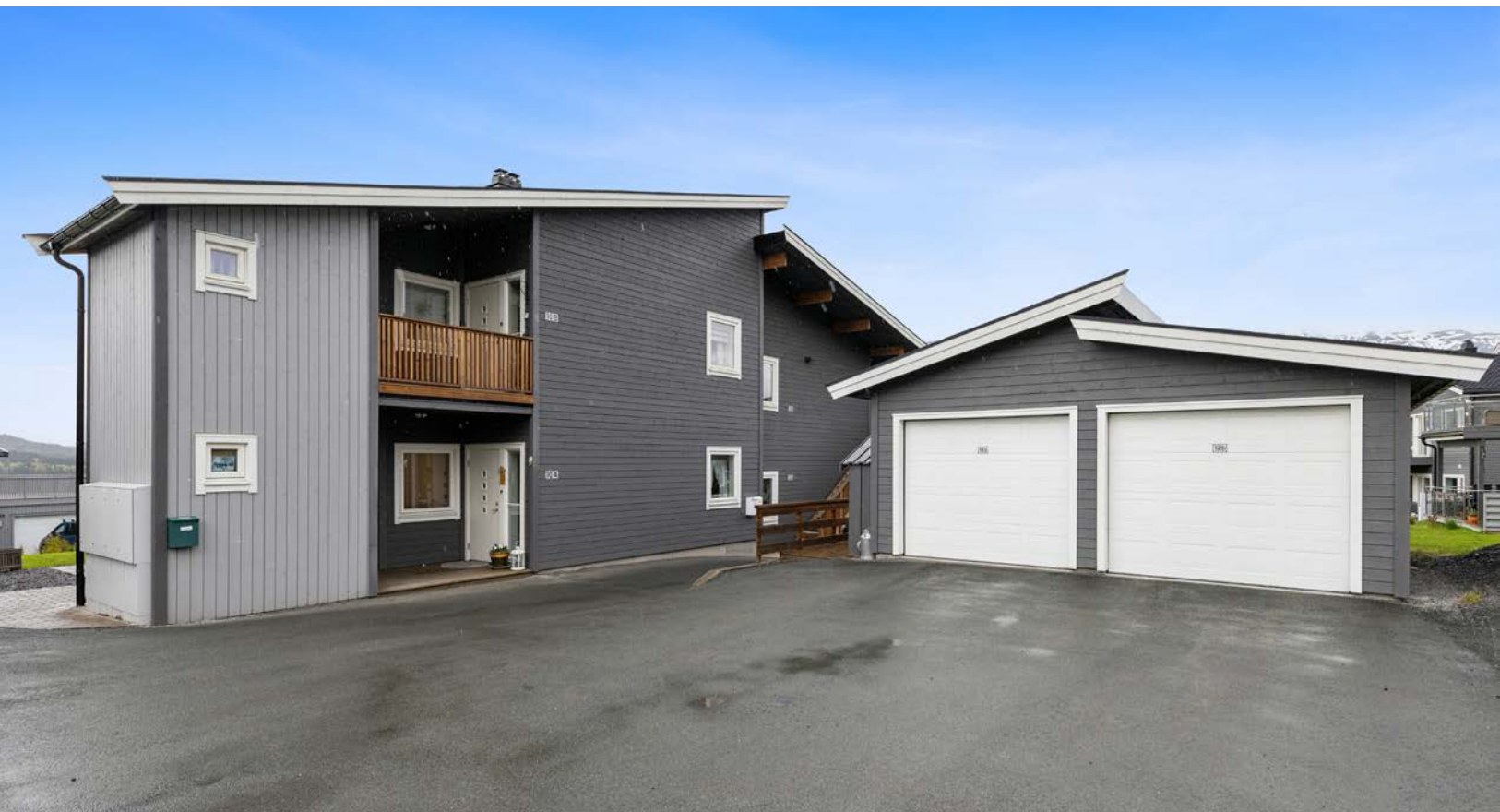
Asflagert uteplass - garasje med elektrisk portåpner
