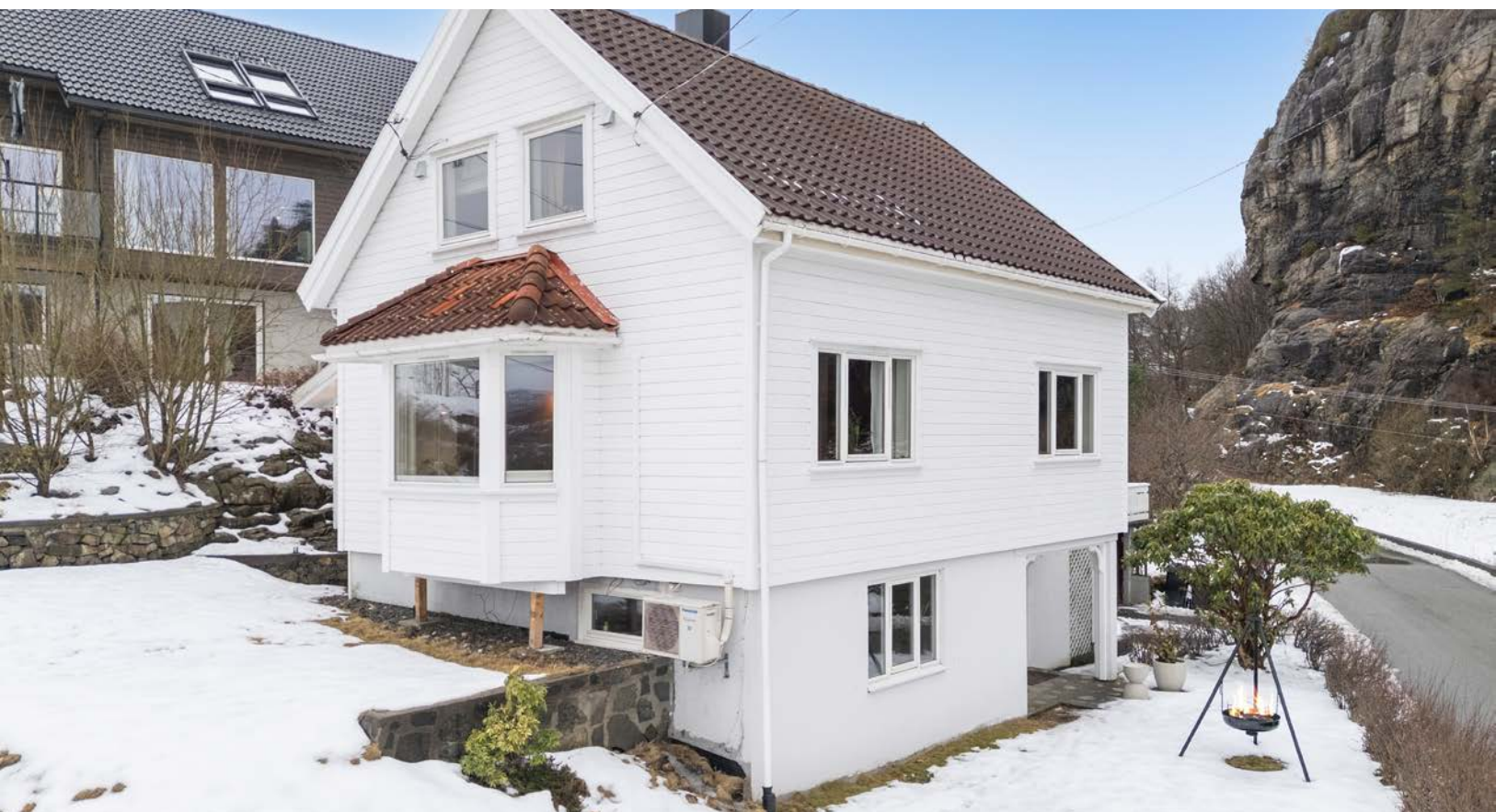
Det er nylig utført drenering på siden ved karnappet og bak, ved tv-stua.
