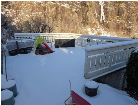
Rekkverk takterrasse og balkong er under 1 meter høye.
