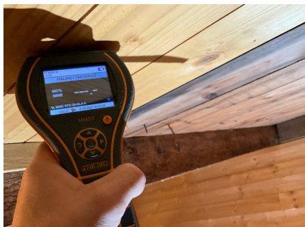
Tørt på befaringsdagen.
