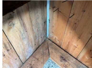
Undertak av trepanel og duk.
