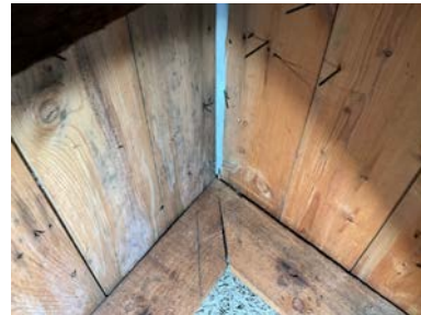
Undertak av trepanel og duk.
