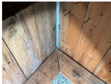
Undertak av trepanel og duk.
