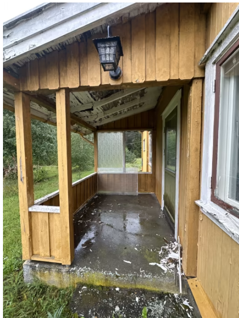
Viser overbygget veranda. Glassfelt ikke montert.
