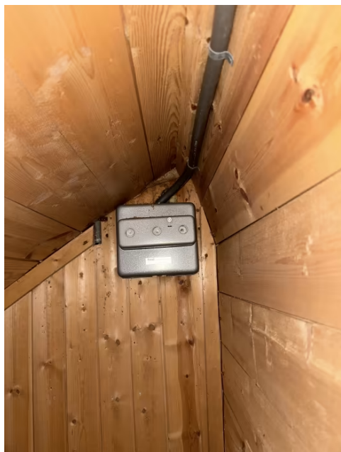
Viser inntak i knekott
