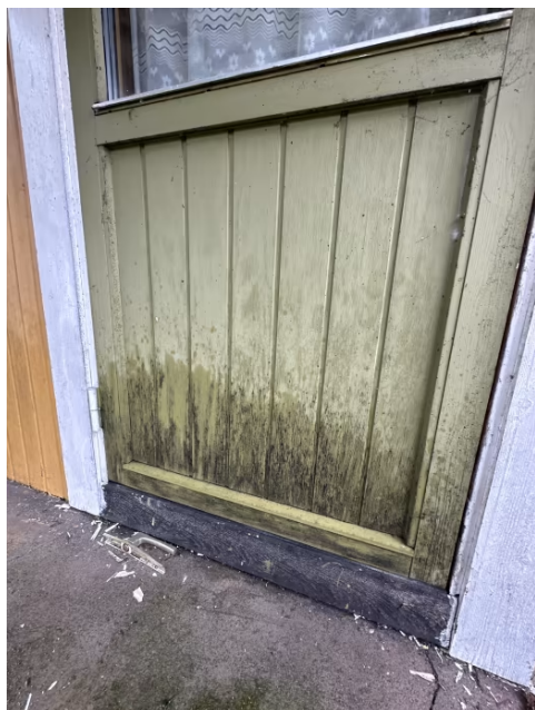
Terassedør med fuktopptrekk.
