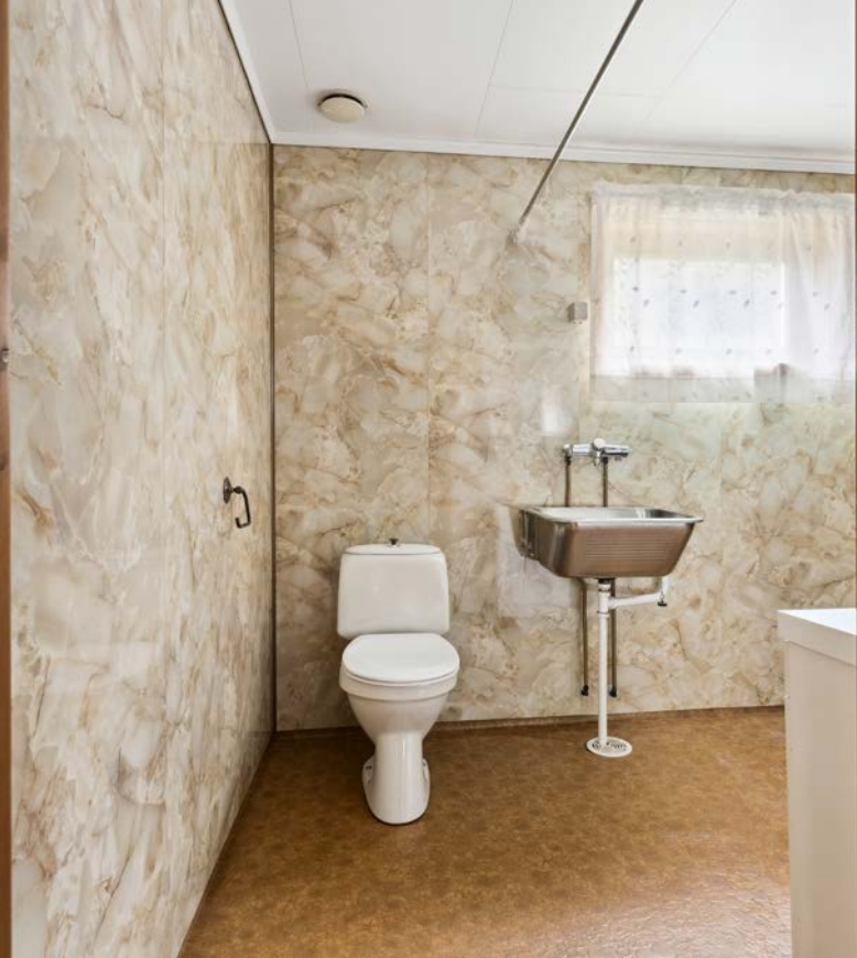
Boligen har et eldre baderom med belegg på gulv og våtromsplater på veggene.
