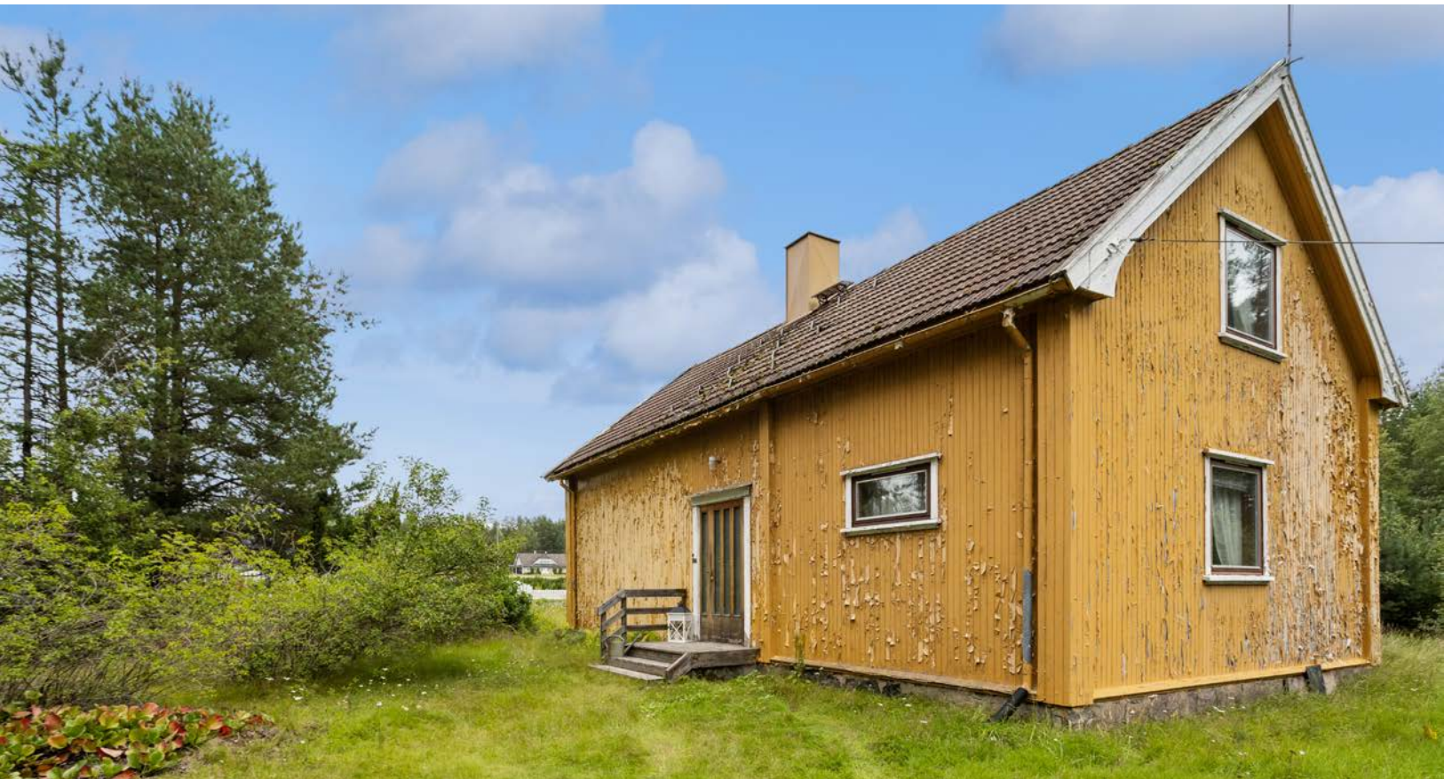
Enebolig antatt oppført i 1900. Tilbygget med kjeller, 1.etasje og 2.etasje mot sørvest ca. 1978.
