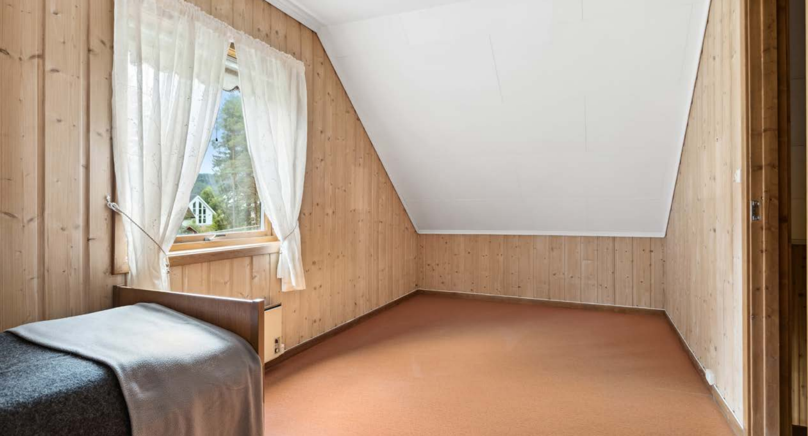
Soverom 3 med belegg på gulv og overflater med trepanel.
