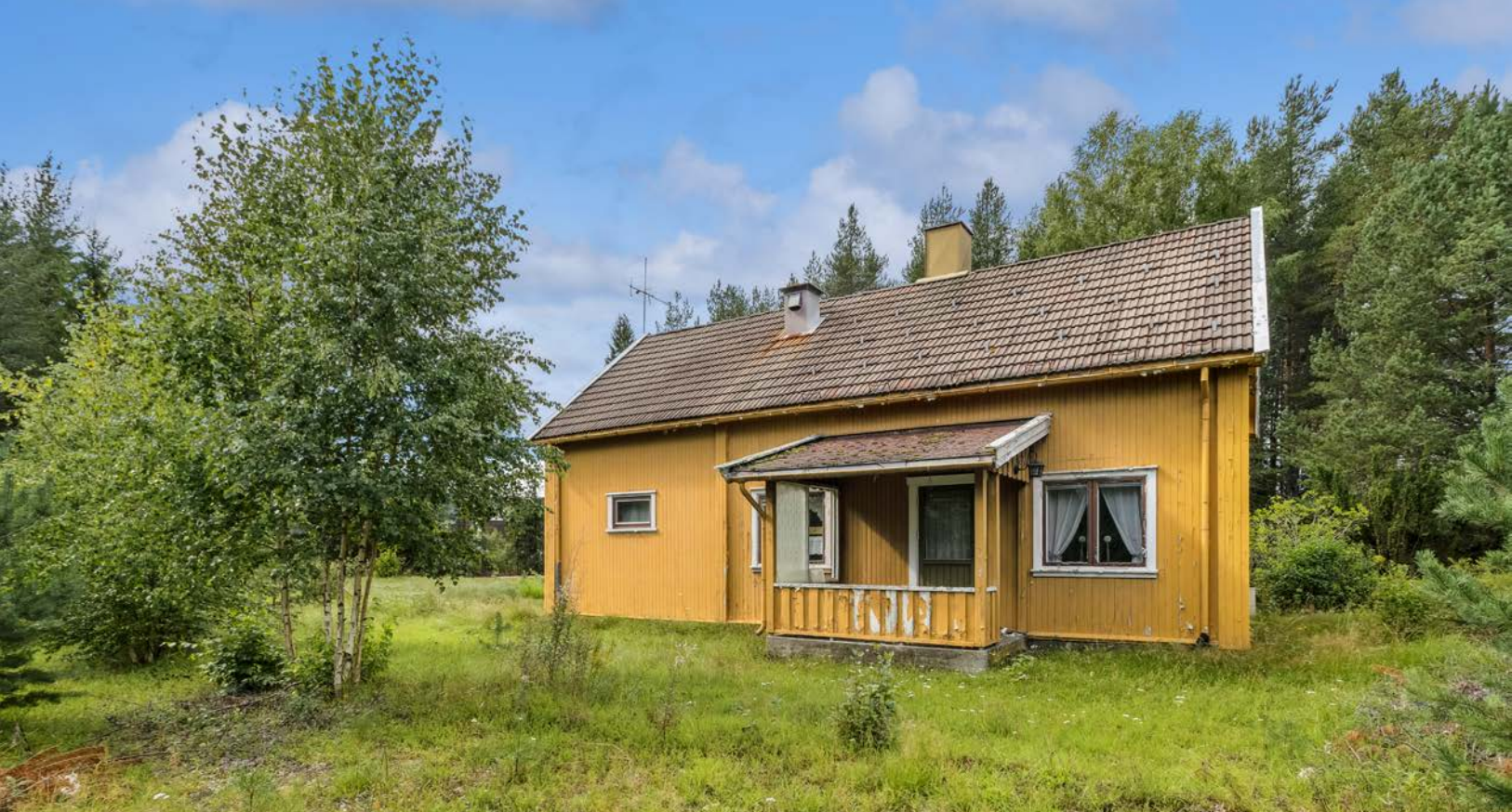
Det ene bruksnummeret er i dag bebyggt med en eldre enebolig over to plan med behov for total oppussing.
