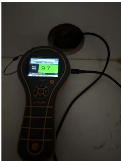
Viser fuktmåling ved hulltaking.
