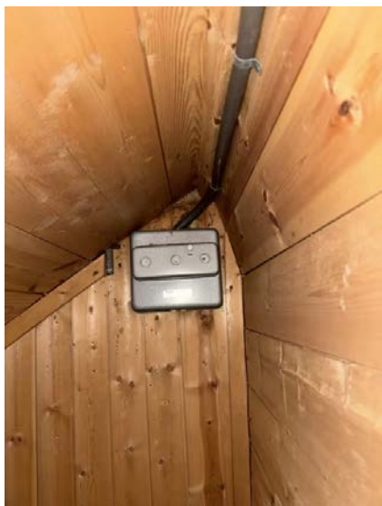
Viser inntak i knekott
