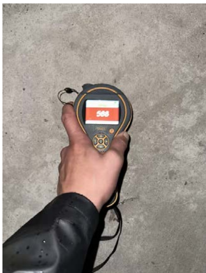
Viser forhøyde fuktverdier mot gulv mot grunn.
