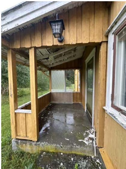
Viser overbygget veranda. Glassfelt ikke montert.
