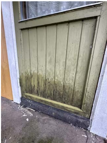
Terassedør med fuktopptrekk.
