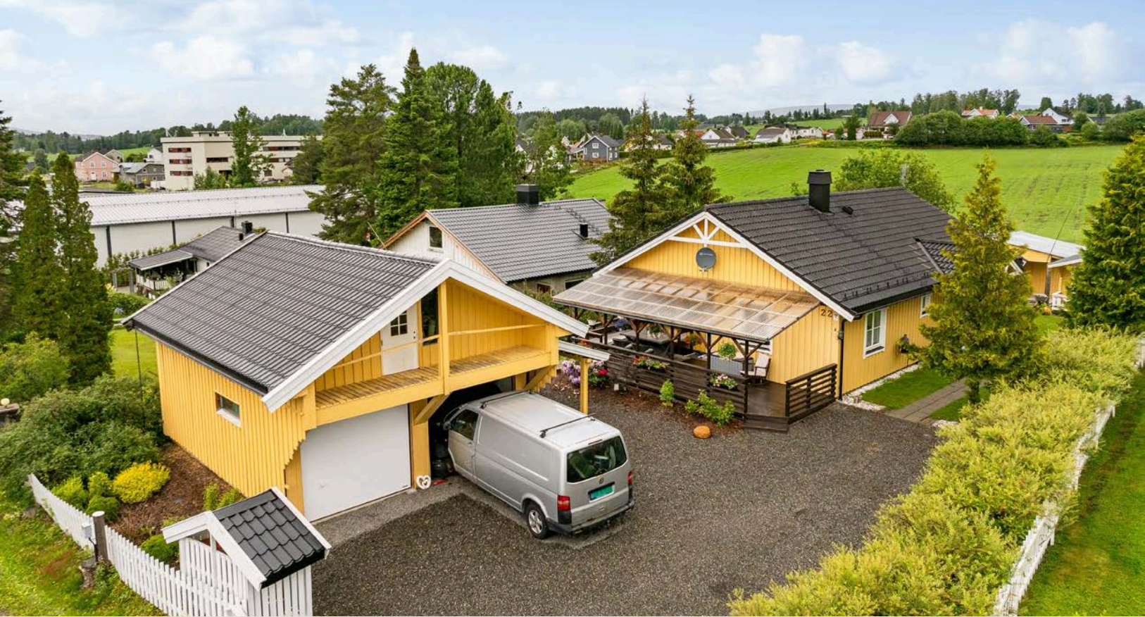
Eiendommen er bebygd med en pen enebolig på én flate, dobbeltgarasje med lagringshems og redskapsbod, lekestue, uthus/hobbysmie og et lite drivhus
