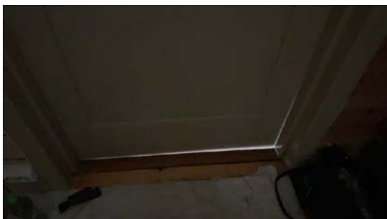
Utettheter i mellom dørblad/karm
