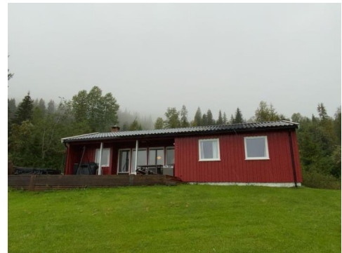
Besiktigelse av taktekke fra bakkeplan.
