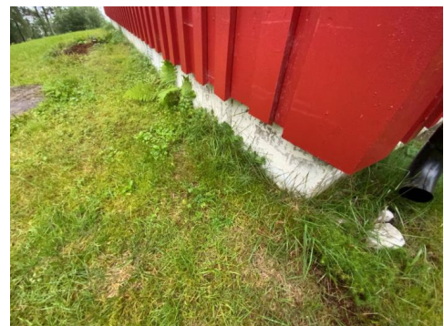
Kontroll av drenering/fuksikring.
