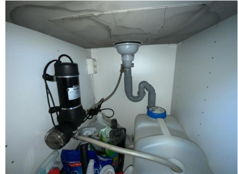
Besiktigelse av røropplegg.
