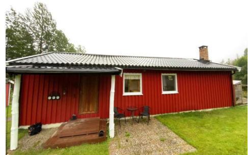
Besiktigelse av taktekke fra bakkeplan.
