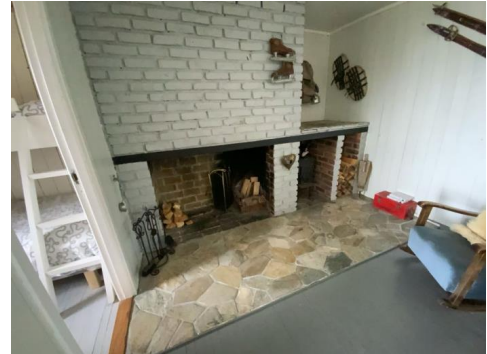
Besiktelse av ildsted.
