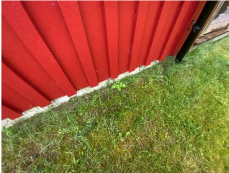
Kontroll av drenering/fuktsikring.
