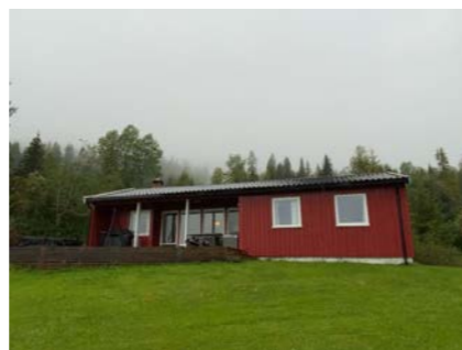
Besiktigelse av taktekke fra bakkeplan.
