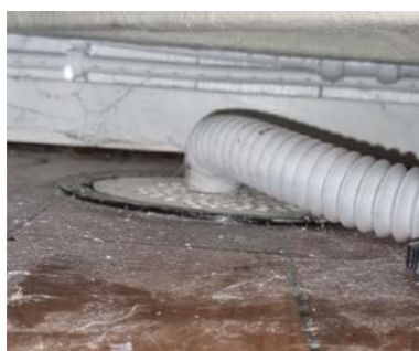
Soilsluk i naborom forøvrig. Sluk fra byggeår.
