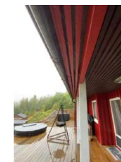
Synlige luftespalter i gesimskasse.
