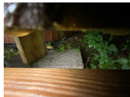
Kontroll av fundament. Utbedringer kan ikke utelukkes på sikt.
