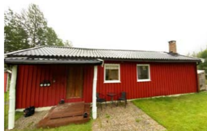
Besiktigelse av taktekke fra bakkeplan.
