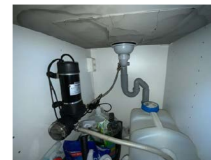
Besiktigelse av røropplegg.
