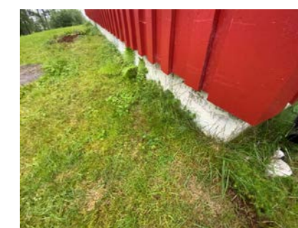
Kontroll av drenering/fuktsikring.
