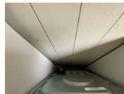
Kontroll bak ovn. Ingen tegn til fuktskader på befaringsdagen.
