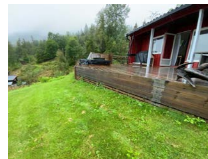
Rekkeverk bør opparbeides.
