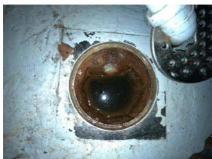
Soilsluk i naborom forøvrig. Sluk fra byggeår.
