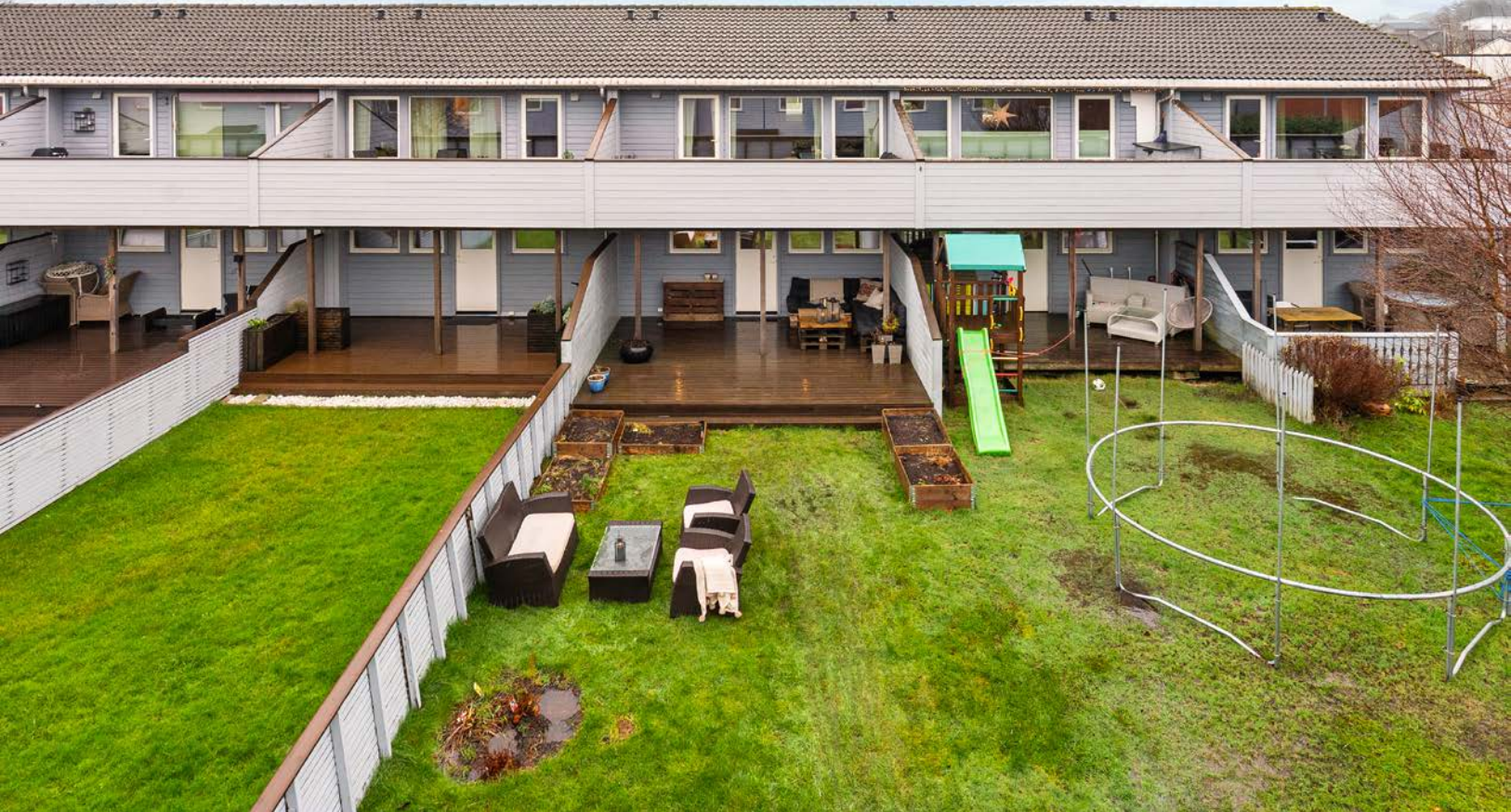
Velkommen til Alkeveien 15 C!
