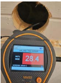
Måling av trefukt i utlektet veggkonstruksjon under terreng.
