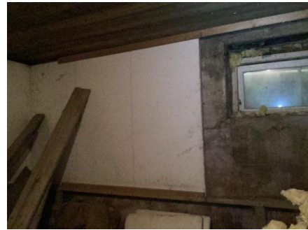
Vegger er noen steder dekket av isolasjon.
