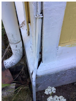
Eksempel på glippe på hjørnekasse.
