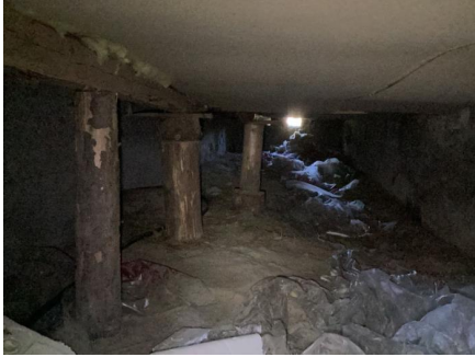
Kryperom under entre.
