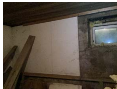
Vegger er noen steder dekket av isolasjon.
