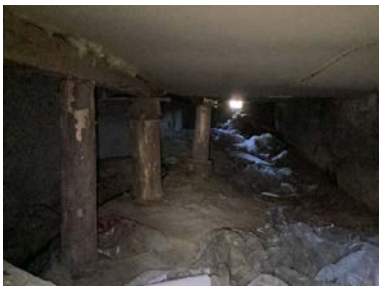
Kryperom under entre.
