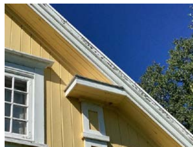
Eksempel på utstikkende del som bør kontrolleres fra oversiden.
