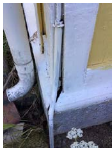
Eksempel på glippe på hjørnekasse.
