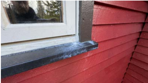
Utvendig omramminger på vinduer er montert helt ned til vannbordet, dette kan føre til vannoppsug/råte i omramming/dekkbord. Det er anbefalt med minimum 6 mm avstand fra nedkant av omramming til det nederste vannbrettet.
