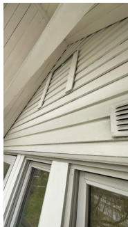
Inspeksjonsluke var fastskrudd, loft er derfor ikke innsisert.
