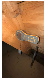
Ved enkel fuktmåling registrerte jeg tørre verdier.
