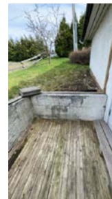
Det mangler rekkverk/annen sikring på forstøtningsmuren(e) ut ifra dagens krav.
