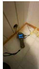
Hulltaking ble foretatt fra gang mot kjølerom. Ved enkel fuktmåling registrerte jeg tørre verdier.
