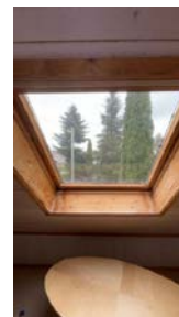
Det er påvist vinduer med fukt/råteskader på soverom på loft. Forholdet gir TG3
