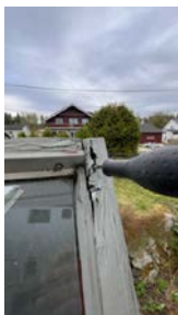
Det er påvist vinduer med fukt/råteskader på soverom på loft. Forholdet gir TG3
