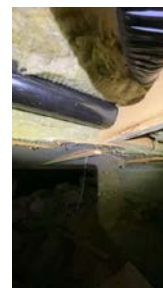
Deler av bjelkelaget var ikke dekket med plater.
