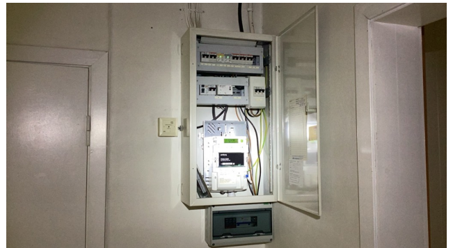
Ledninger er ufagmessig koblet i kjeller.
