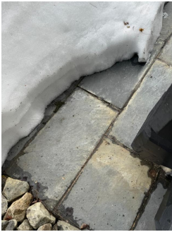
Bilde av løs skifer og krakelert fugemasse.
