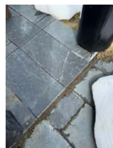
Bilde av løs skifer og krakelert fugemasse.
