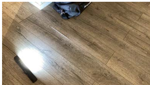
Skadet laminatgulv
