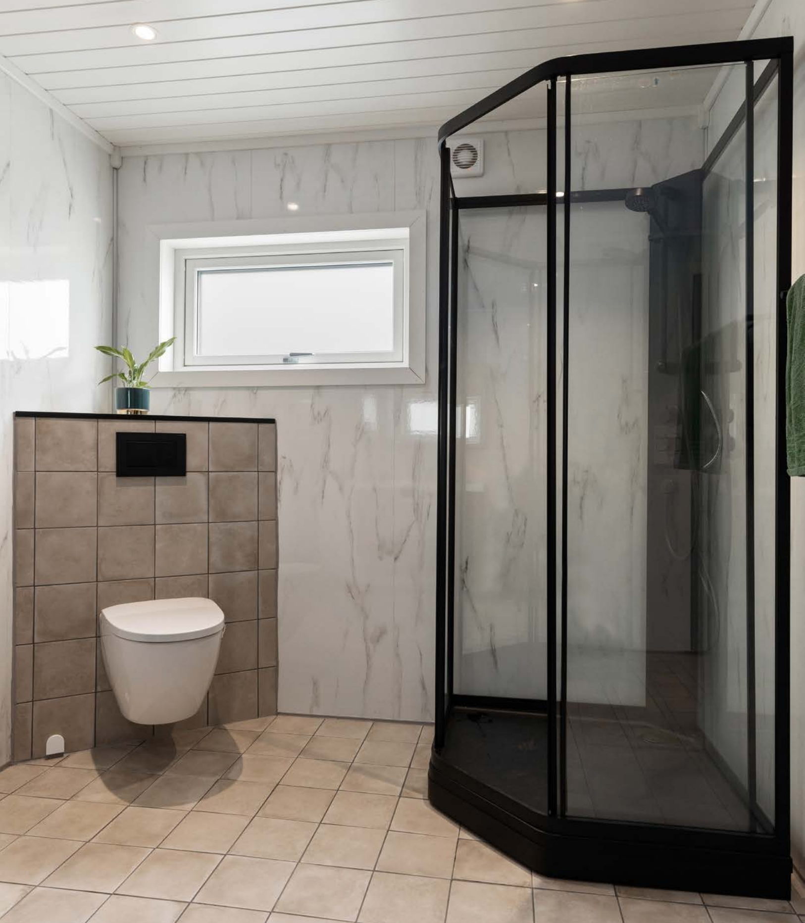
Vegghengt toalett plassert i hjørnet, praktisk og enkelt. Dusjkabinett med sorte detaljer skaper en helhet i rommet.
