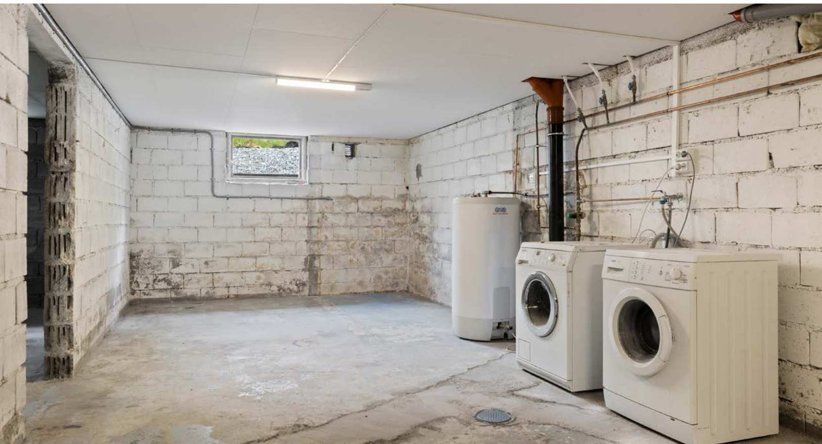
Uinnredet grovkleller/vaskekjeller med lagringsplass. Varmtvannstank plassert i kjeller. Vaskemaskiner i kjeller medfølger ikke salget.
