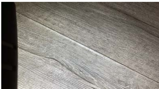
Skadet laminatgulv
