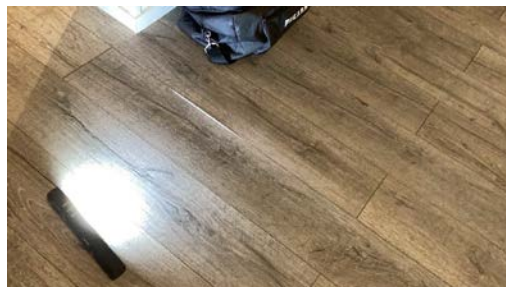
Skadet laminatgulv
