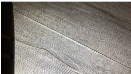
Skadet laminatgulv
