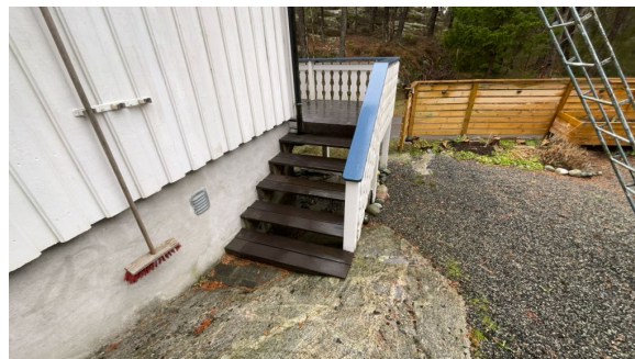
Utvendig trapp i tre.
