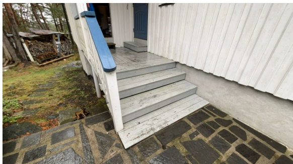
Utvendig trapp i tre.
