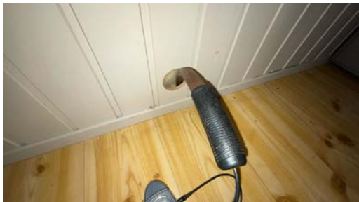
Hulltaking mot vaskerom.
